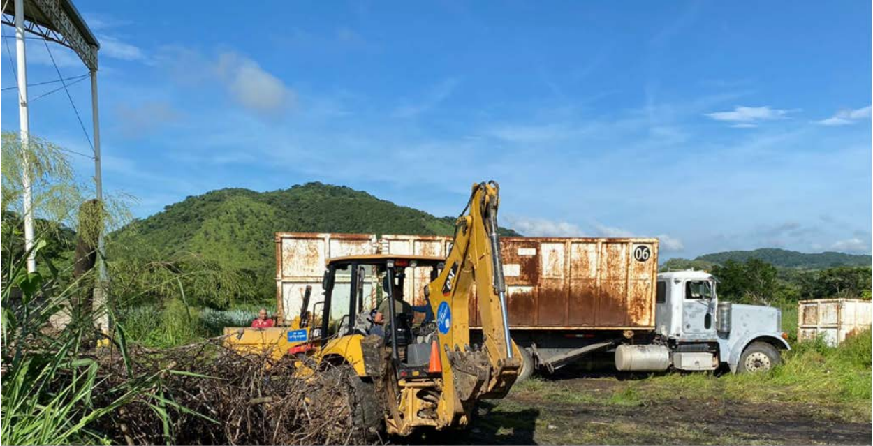
Se realizó limpieza y traslado de residuos sólidos urbanos al Relleno Sanitario Intermunicipal.
