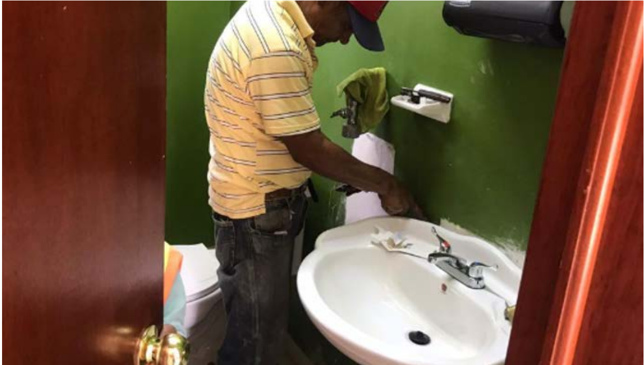
Colocación de sanitario completo en oficinas operativas del Relleno Sanitario Intermunicipal
