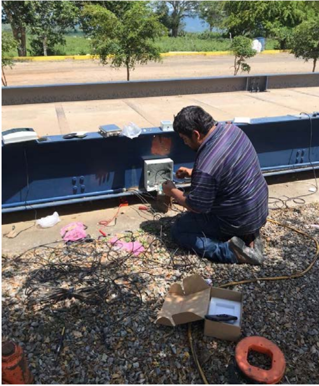
Mantenimiento y modernización de báscula mediante la instalación de tablero inalámbrico, con una inversión de $ 56,800.00 (Cincuenta y seis mil ochocientos pesos 00/100 M.N.).
