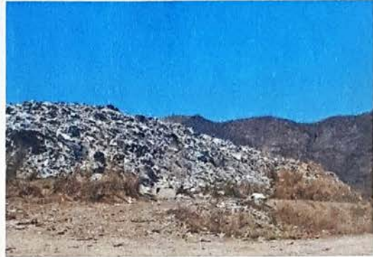
Residuos expuestos y pendientes en talud pronunciadas fuera de norma
