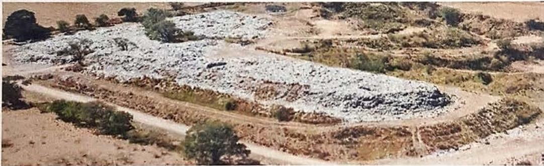
Residuos expuestos y pendientes en talud pronunciadas fuera de norma
