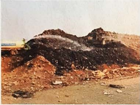
Conato de Incendio debido a la exposición de los residuos
